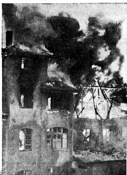
Au mois de mai, le Département d'émailage des Tréfileries réunies de Bière fut la proie des flammes. Il y eut pour plus d'un demi-million de dégâts.
