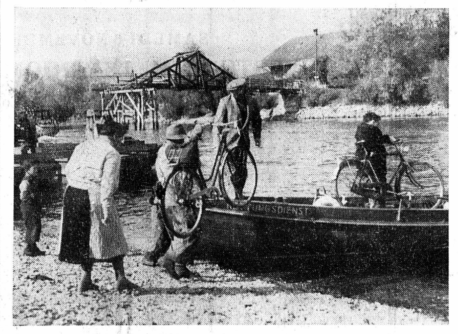
Un chaland plein de sable s'échoua au-dessus du pont en bois de Gottstadt; déporté par le courant il vint frapper les piliers du pont dont il fit s'écrouler deux arches, détruisant ce pont qui devait d'ailleurs être démolit au mois de novembre pour être reconstruit par des sapeurs. La circulation est assurée par un bac provisoire qui transporte personnes et marchandises sur l'autre rive. — Notre photo montre des cyclistes à l'embarquement. A l'arrière-plan, les restes du pont démolit.
