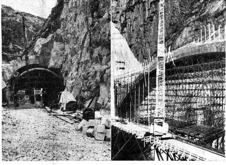
Aidée par le beau temps automnal, la construction du nouveau Pont du Diable, dans les gorges des Schöllenen, avance rapidement. La partie supérieure du pont, qui a été construit à l'aide d'un échafaudage en tubes d'acier Mannesmann, est terminée. — Nos photos : à droite, les pierres formant l'arc ; à l'arrière plan, le mur que traverse la route pour arriver sur le pont. A gauche : le nouveau tunnel qui aboutira au « Teufelbrücke ».
