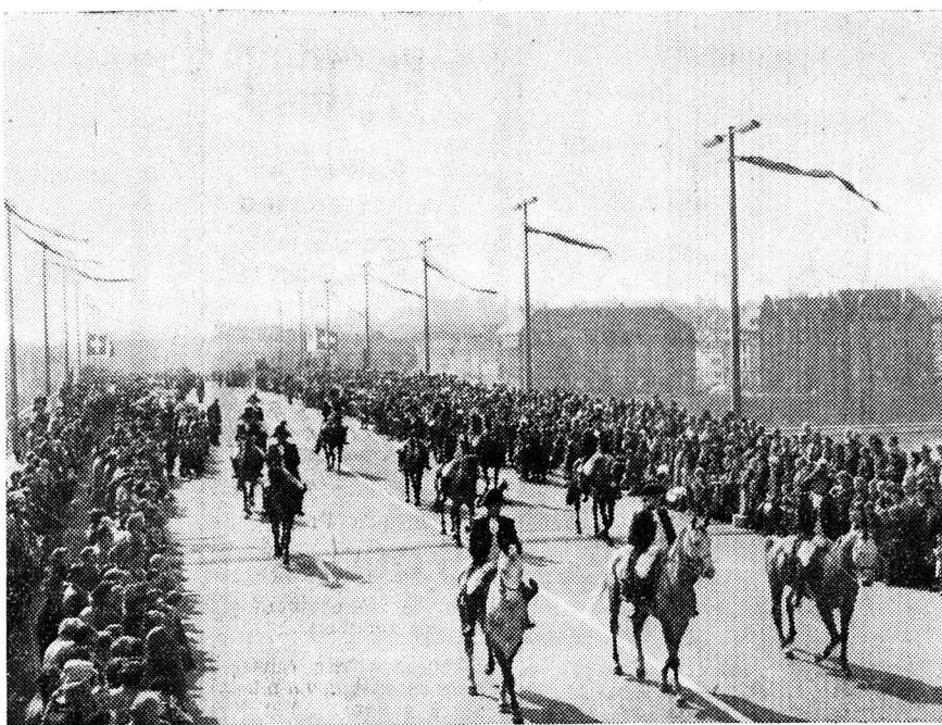
Le nouveau pont de Saint-Alban a été inauguré officiellement. Un nombreux public assistait à la cérémonie. Le pont mesure 250 m. de long, 22 m. de large. La longueur d'arche est de 135 m. C'est la plus grande de Suisse. Après l'inauguration du pont, des groupes représentant tous les usagers de la route ont défilé sur le pont de Saint-Alban pavoisé.
