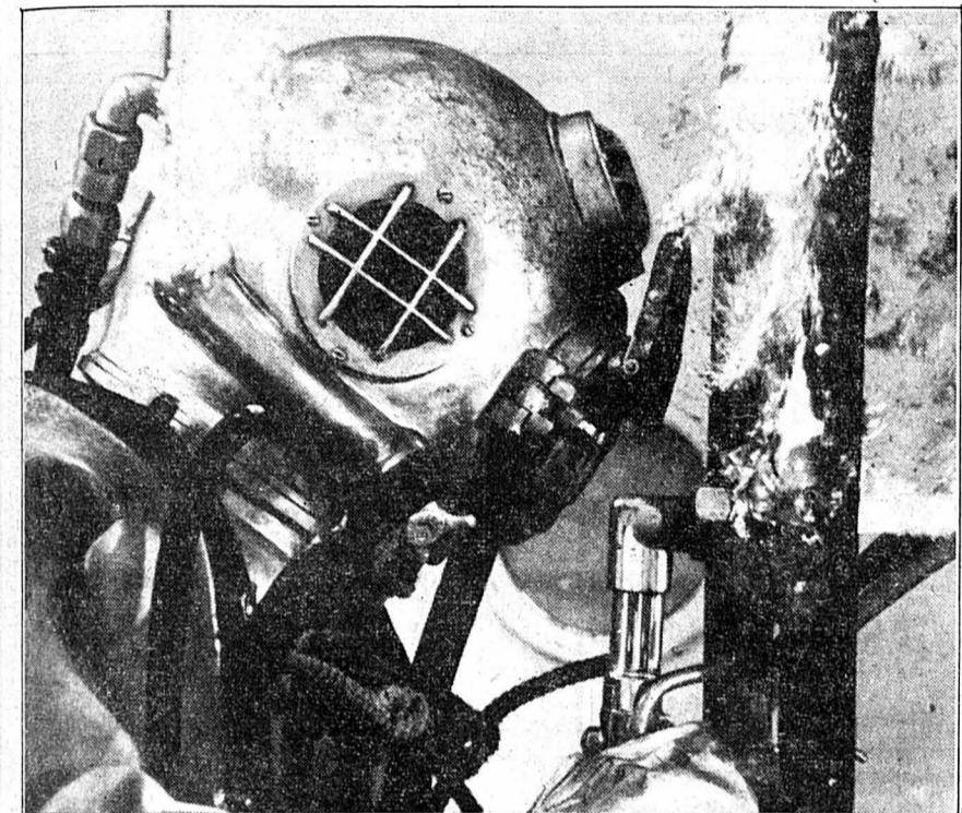
Un scaphandrier de la marine militaire américaine utilise une torche spécialement construite pour les fonds sous-marins, afin de découper une épave.
