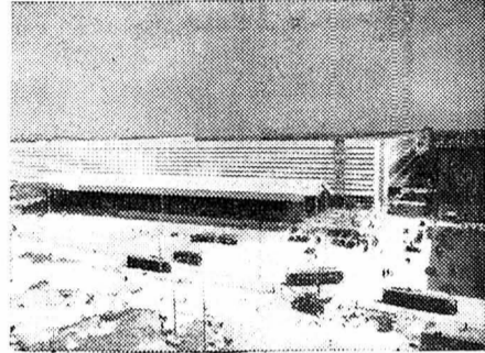
La nouvelle gare de Rome, splendide construction qui compte parmi les plus imposantes du monde.
