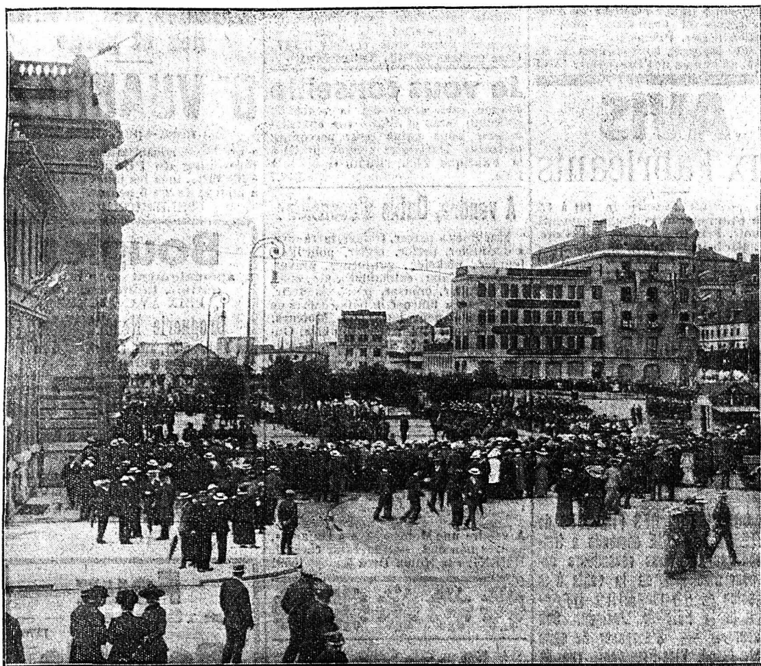
Le Tir cantonal: La formation du cortège d'ouverture devant la gare.
