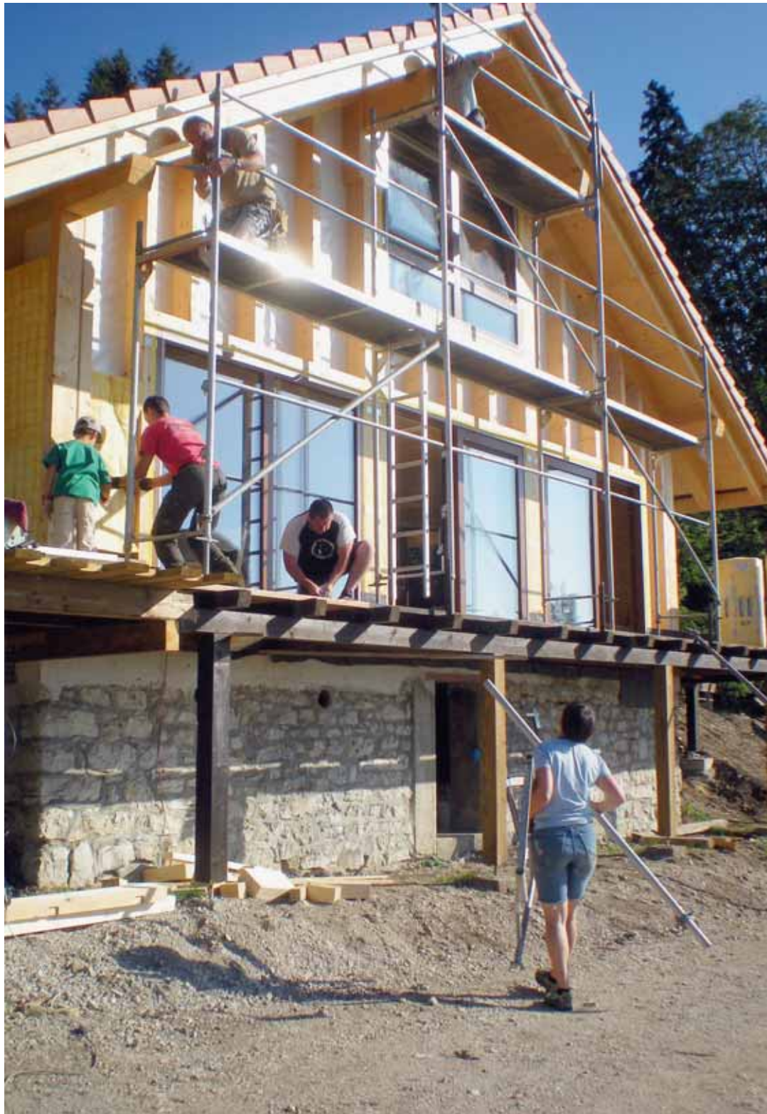
De nombreux bénévoles ont œuvré à la rénovation du chalet des Lattes, propriété du ski club. Datant de 1946, il était dans un état vétuste et délabré. La fin des travaux est prévue pour octobre. SP
