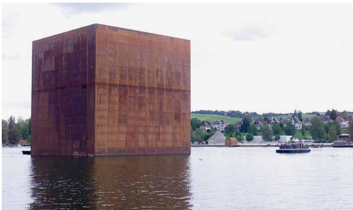
Morat. Une navette permettait au public d'accéder au cube flottant conçu par l'architecte Jean Nouvel et qui abritait deux expositions. RICHARD LEUENBERGER
