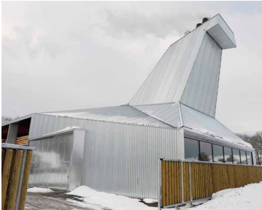
Le chauffage à distance au bois de Lignièrès a été mis en fonction en septembre 2009. Il permet de chauffer plus d'une centaine de bâtiments, mais il n'est pas encore utilisé à pleine capacité. ARCHIVES RICHARD LEUENBERGER
