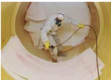
3. Pose de la mousse perméable à l'air entre la citerne existante et l'enveloppe intérieure
