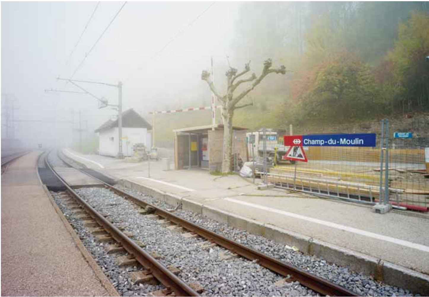
Brouillard automnal et travaux sur le site de l'ancienne gare de Champ-du-Moulin, démolie depuis fin septembre. CHRISTIAN GALLEY
