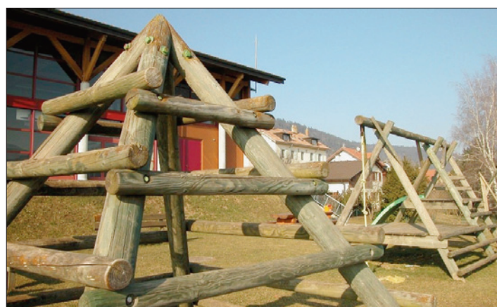
LA REBATE Les installations de jeux actuelles ne répondent plus aux normes de sécurité.
