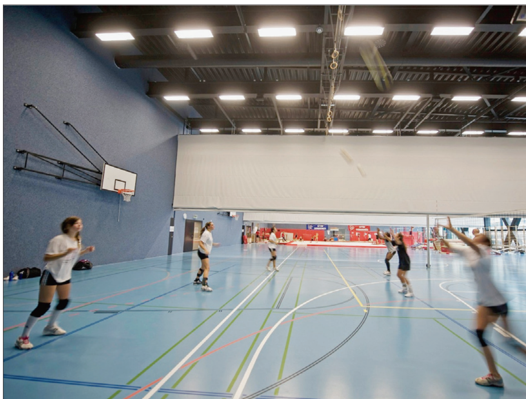
BOL D'AIR FRAIS La prise d'air des salles de gymnastique était située sur la toiture métallique du stade. Déplacée dans un endroit moins exposé au soleil, elle insufflera de l'air plus frais.
