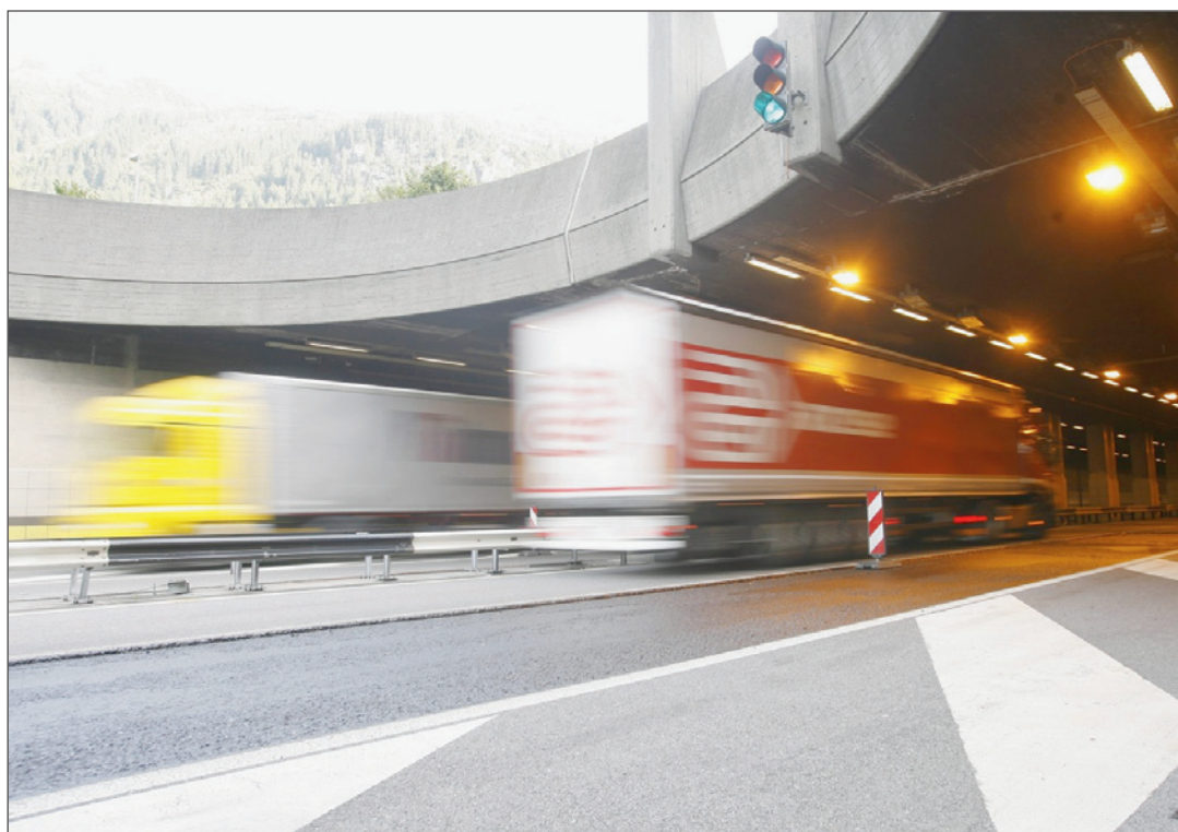
GOTHARD Inauguré en 1980, le tunnel routier va faire l'objet d'une réfection complète entre 2020 et 2025. Selon les experts, ces opérations nécessiteront 900 jours de fermeture complète.
