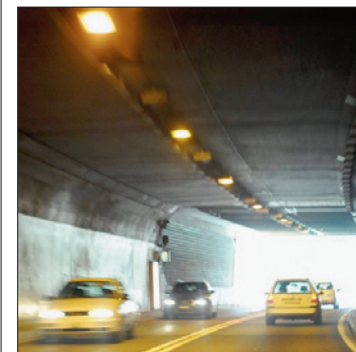
TUNNEL Un ou deux tubes sous La Vue-des-Alpes? (KEYSTONE)
