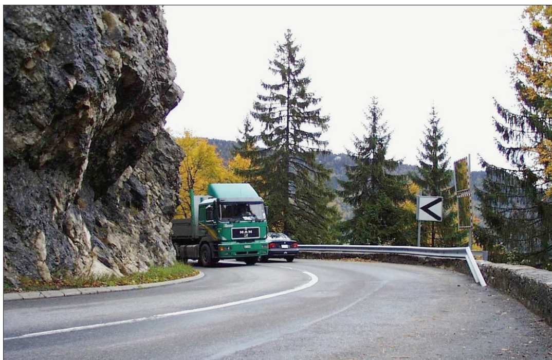
VIRAGE DE LA MORT En 1837, lors de la construction des murs de soutènement et de la route, on n'imaginait pas que des 40 tonnes allaient y transiter. Outre l'instabilité du mur, le rayon du virage (22 mètres) oblige les camions à emprunter toute la chaussée. (ARCHIVES)
