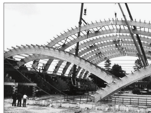
TOIT Il a été construit et posé en 1981.
