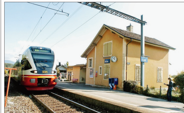
GARE DE BÔLE. Les travaux de démolition nocturnes auront lieu la semaine prochaine. (ARCHIVES DAVID MARCHON)
