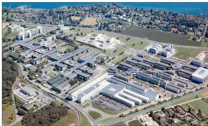
EPFL La première phase du projet de centrale solaire photovoltaïque portera sur 20 000 m 2 . (KEYSTONE)
