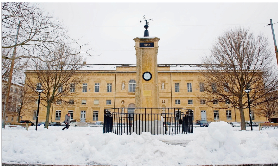
TRAVAUX L'escalier est du Collège latin, ainsi que des locaux en sous-sol, seront assainis dans ce bâtiment faisant partie du patrimoine administratif de la Ville.
