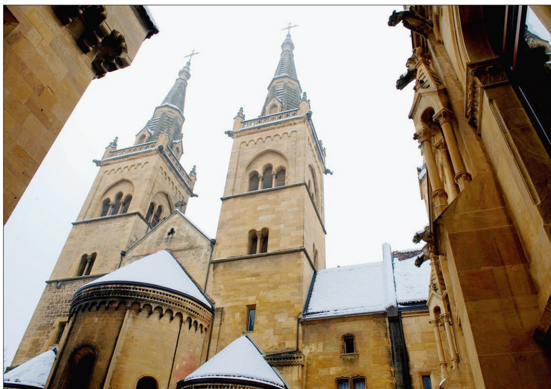
EST DE LA COLLÉGIALE Premiers échafaudages ce printemps.
