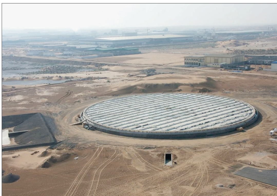
SOLAIRE Le concept du CSEM consiste à équiper les toits des immeubles d'une mini île solaire, d'un réservoir d'eau et de l'appareil, actuellement en gestation chez SolarCool, pour produire un système de climatisation carburant à l'énergie renouvelable.
