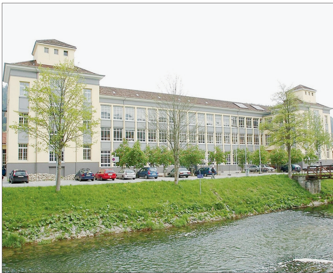
COUVET Le Cnip est installé dans les anciens locaux de l'usine Dubied depuis le début des années 2000.
