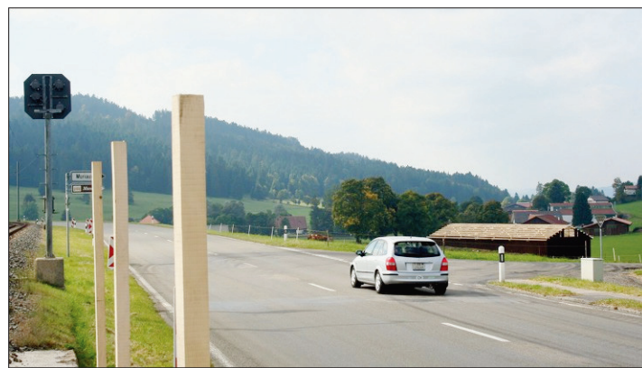
CARREFOUR Les prémices du chantier au carrefour est de Muriaux ont été posées en fin de semaine passée.
