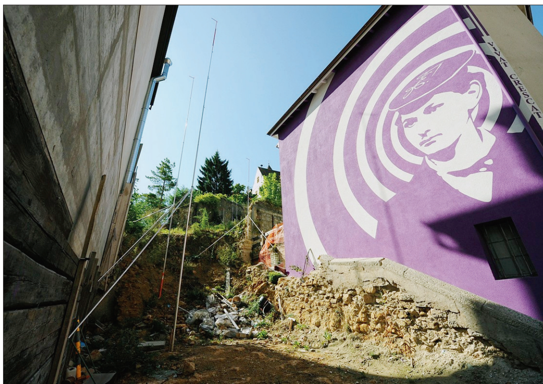
RUE DE L'ECLUSE Les gabarits sont toujours là, pour indiquer les dimensions du projet. (CHRISTIAN GALLEY)
