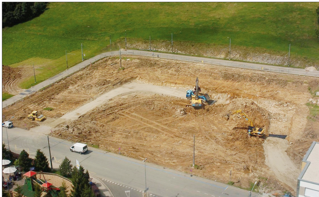
CHANTIER Les travaux de la future Migros des Eplatures ont démarré il y a quelques jours. (RICHARD LEUENBERGER)
