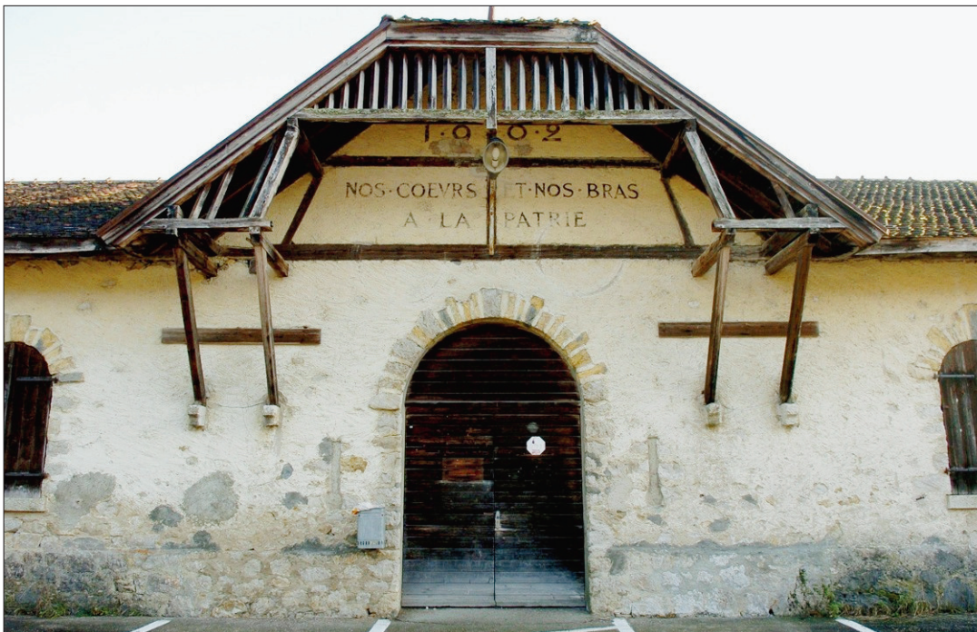
STAND DE TIR L'ancien bâtiment pourrait être réhabilité en crèche, école enfantine et vestiaires.
