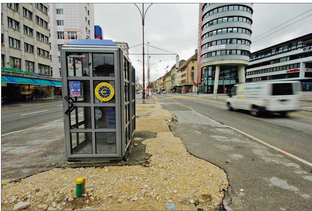
CHANTIERS Le tronçon compris entre la Grande Fontaine et la rue du Dr-Coullery sera l'objet de travaux durant 20 semaines, à compter du mois de mai. La circulation y sera réduite. (CHRISTIAN GALLEY)
