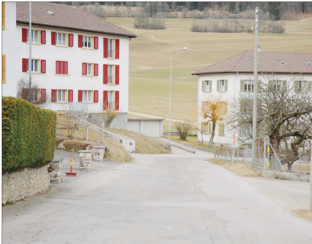
RACCORDEMENT Dès la fin du mois de mai, les travaux de mise en séparatif débiteront sur la rue Sandoz-Travers, qui sera entièrement remise en état. Un cheminement piétonnier sera aménagé. (ARCHIVES FANNY NOGHERO)
