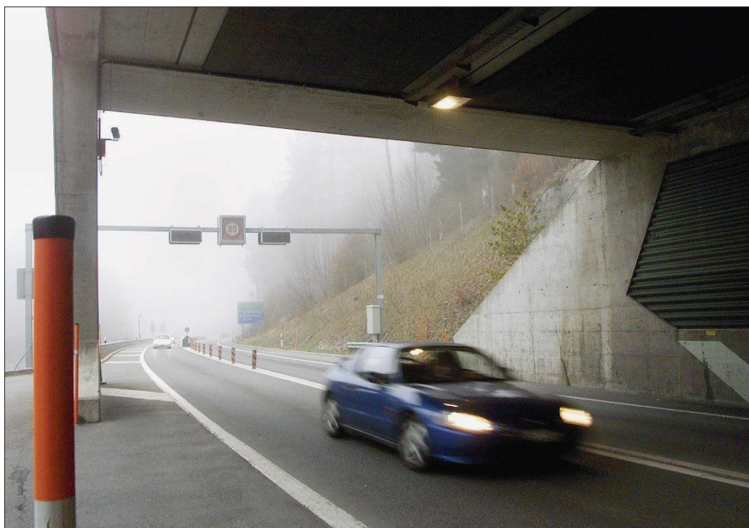
DYNAMIQUE FACILITÉE Le tunnel sous La Vue-des-Alpes a permis à la fois aux Chaux-de-Fonniers d'aller travailler ailleurs et aux habitants des autres régions d'aller travailler dans le Haut. (DAVID MARCHON)
