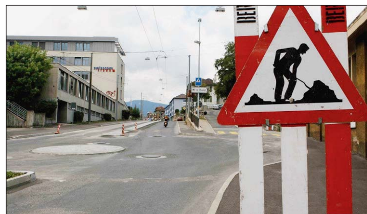
TRAFIC Le carrefour de Vauseyon, ici pendant les travaux.
