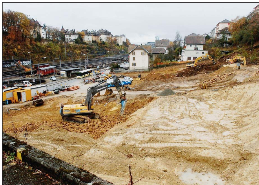
RUE DES FAHYS Le chantier a débuté voici quinze jours. Il devrait s'achever à l'été 2009.
