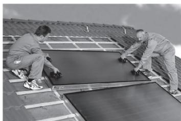
Une combinaison idéale: un chauffage au mazout et une installation solaire thermique. Le montage est simplifié par l'utilisation de composants modulaires.
