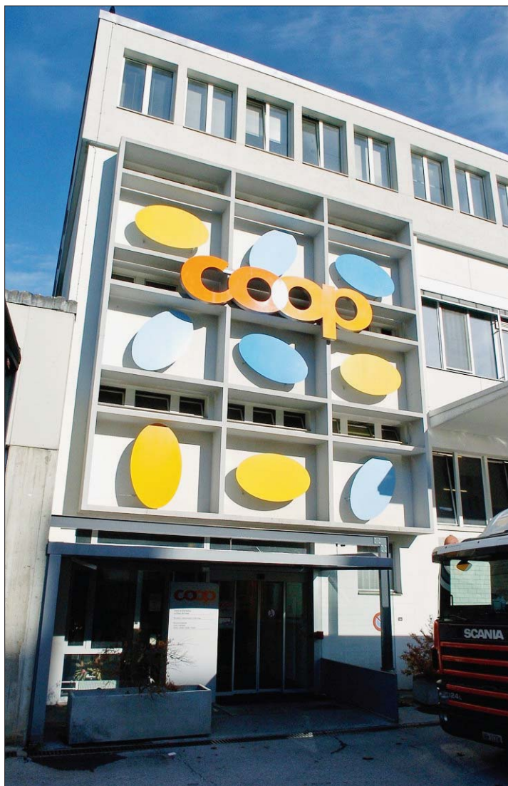
LA CHAUX-DE-FONDS La centrale de distribution de Coop accueille également la boulangerie industrielle. (DAVID MARCHON)
