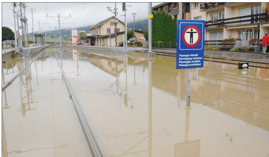
COURTELARY Gare et aiguillages ont été inondés.
