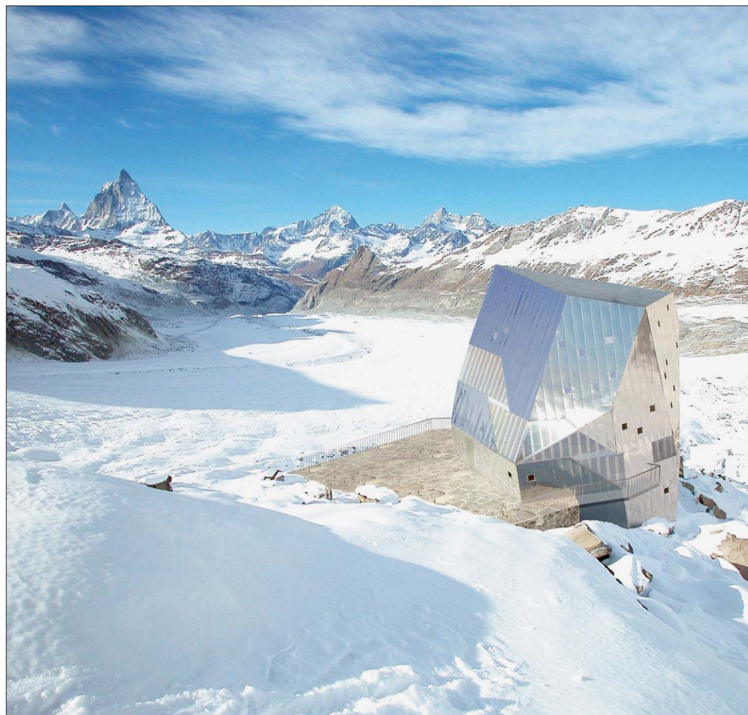
ALPES La construction de la future cabane du Mont-Rose débutera en été 2008. Le financement a pu être réuni pour cette réalisation à la pointe de la technique en matière d'écologie, d'autonomie et de durabilité (ici, une vue virtuelle, avec le Cervin à l'arrière-plan). Le coût du projet est devisé à 5,7 millions de francs. Maître d'œuvre, le Club alpin suisse a pu réunir 2,15 millions de francs. L'Ecole polytechnique fédérale de Zurich, qui a conçu l'ouvrage, a trouvé des sponsors pour le solde. Située à 2810 mètres d'altitude, la cabane pourra accueillir 120 alpinistes à partir de 2009. L'actuelle cabane, qui date de 1894, abrite 160 lits. Le nouvel édifice bénéficiera de matériaux de pointe pour son isolation. Ses formes architecturales répondent à des exigences énergétiques avec panneaux solaires et récupération de neige fondue. L'autarcie sera pratiquement totale. L'actuelle cabane est située au pied du Mont-Rose et domine le glacier du Gorner, terminus de la ligne ferroviaire du Gornergrat. Le Mont-Rose, avec la Pointe Dufour (4634 m), l'un de ses neuf pics, est le deuxième plus haut sommet des Alpes. (KEYSTONE)
