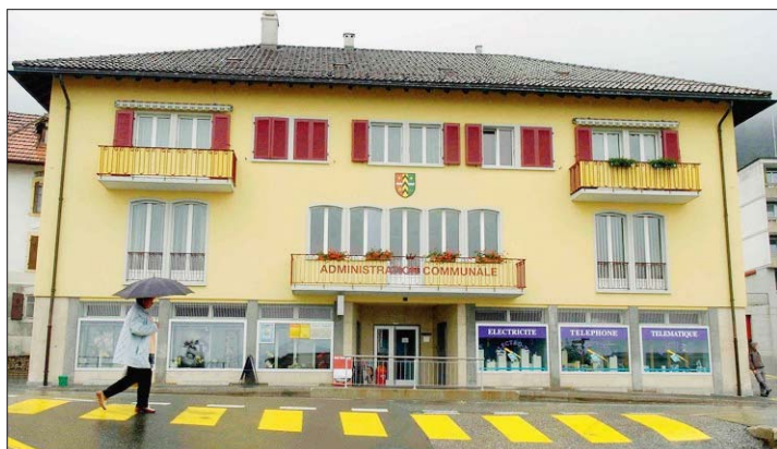
CRÉDIT L'enveloppe de 300 000 fr. pour la rénovation complète du bureau communal (1er étage) a été refusée par le législatif bornicant. (DAVID MARCHON)
