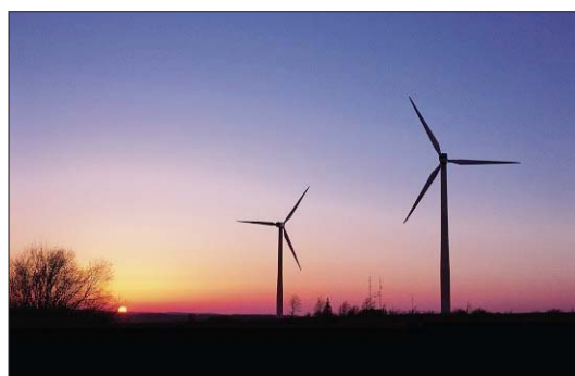
HÉLICES Elles devraient tourner d'ici le printemps 2010 au plus tard sur les crêtes neuchâteloises. (SP)
