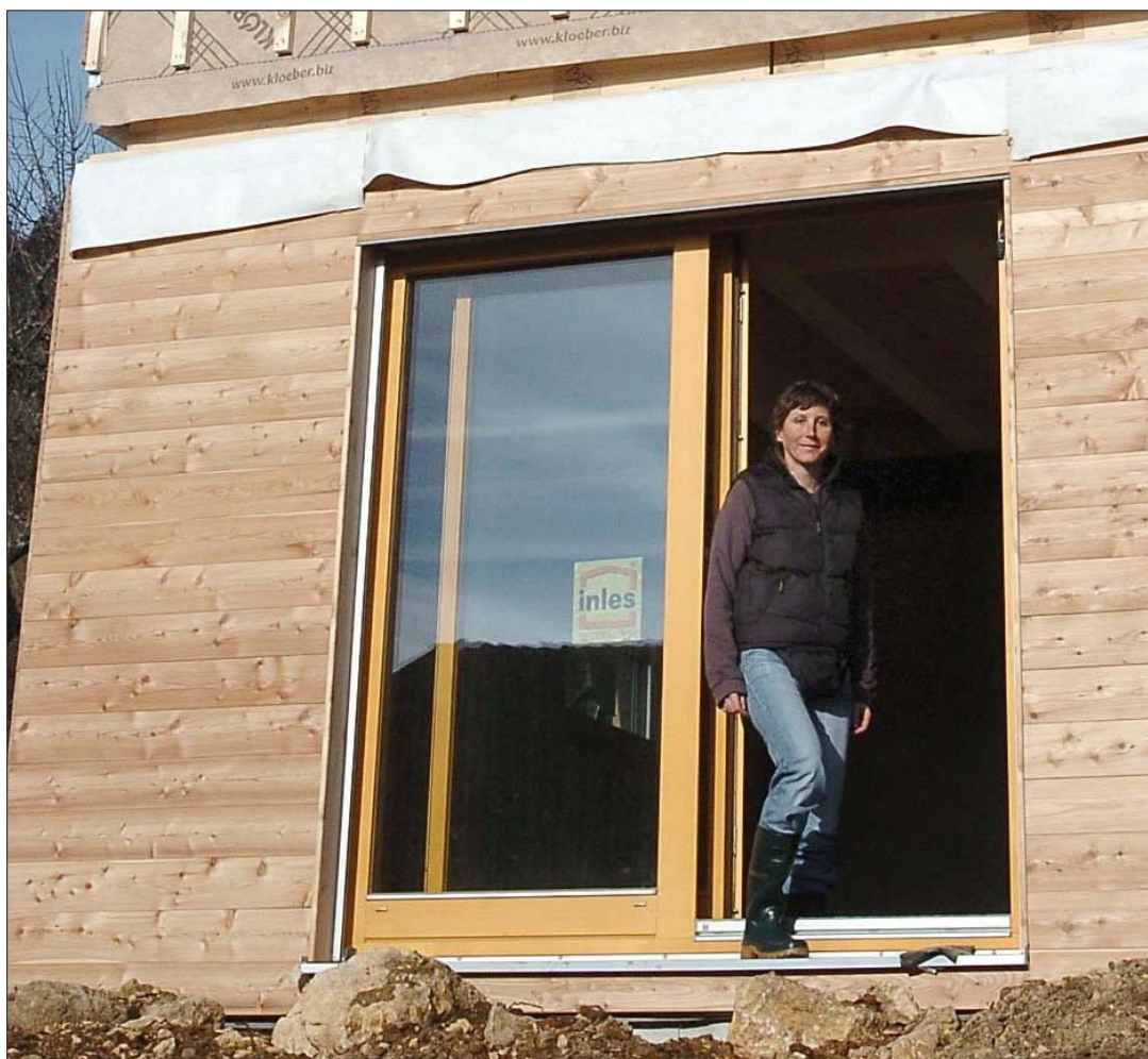
SOUS TOIT La maison de Catherine Chollet a été construite en deux jours.
