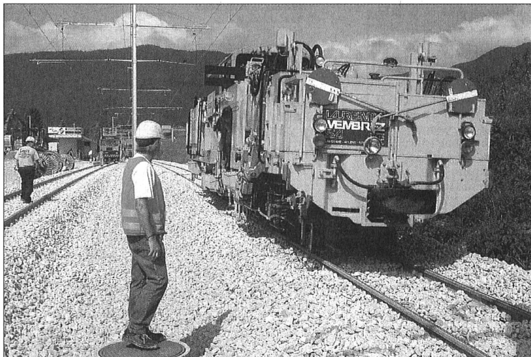
La bourreuse poussait hier le ballast sous les traverses des nouvelles voies. PHOTO BARDET
