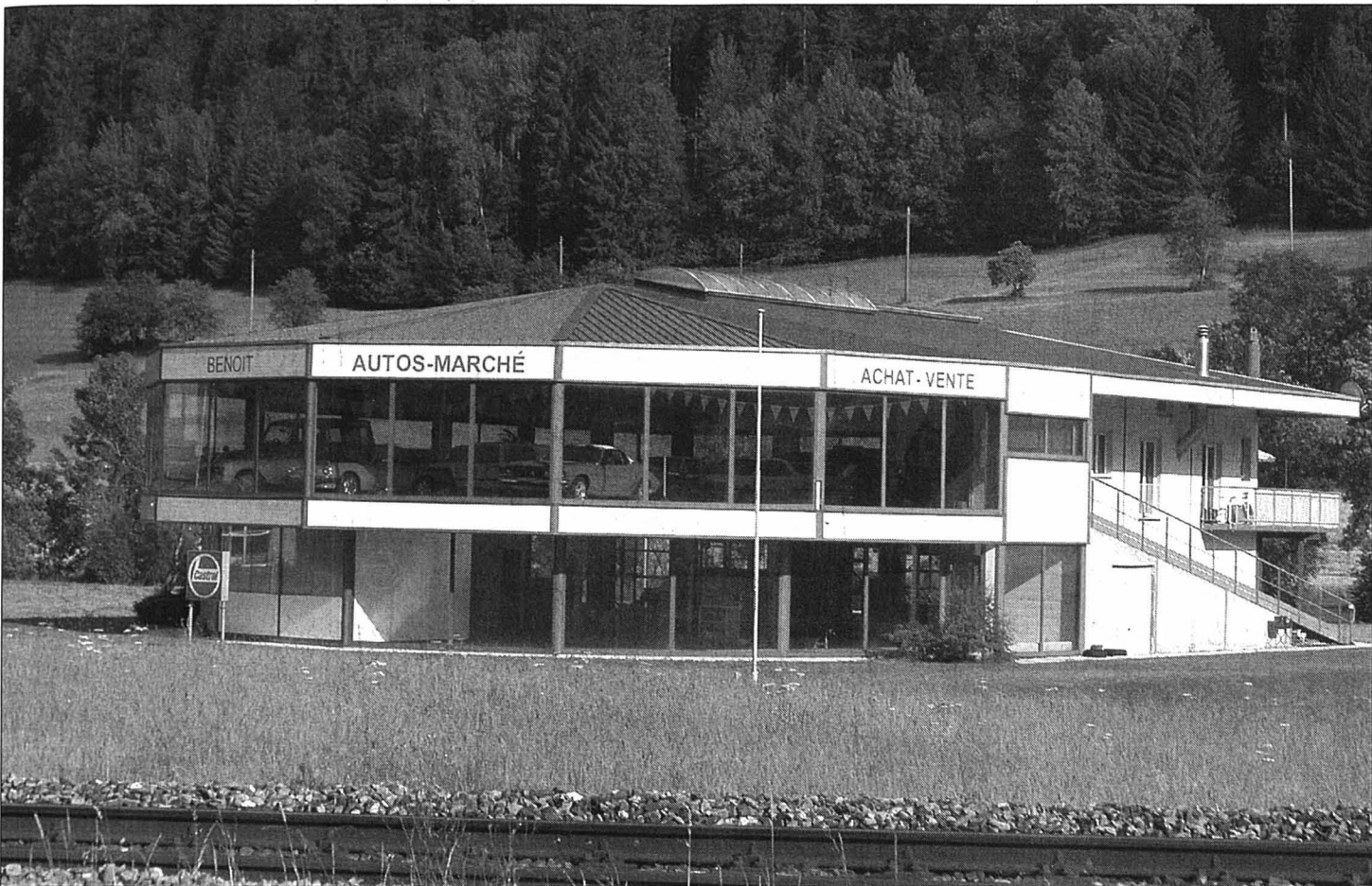
L'entreprise s'est installée dans les locaux au rez-de-chaussée de l'ancienne halle de vente de voitures. PHOTO DE CRISTOFANO
