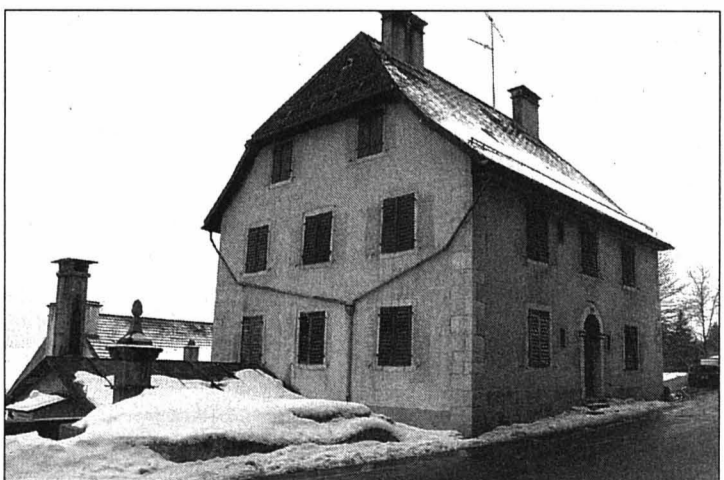
La maison Grand-Rue 27, datant du XVIII e siècle, sera sans doute démolie prochainement.
