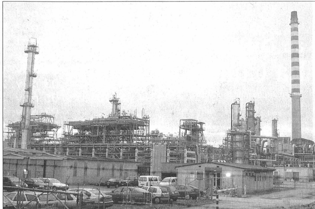
Le complexe pétrolier sis à Cressier va s'enrichir d'une nouvelle unité pour la fabrication d'hydrogène. PHOTO ARCH-MARCHON
