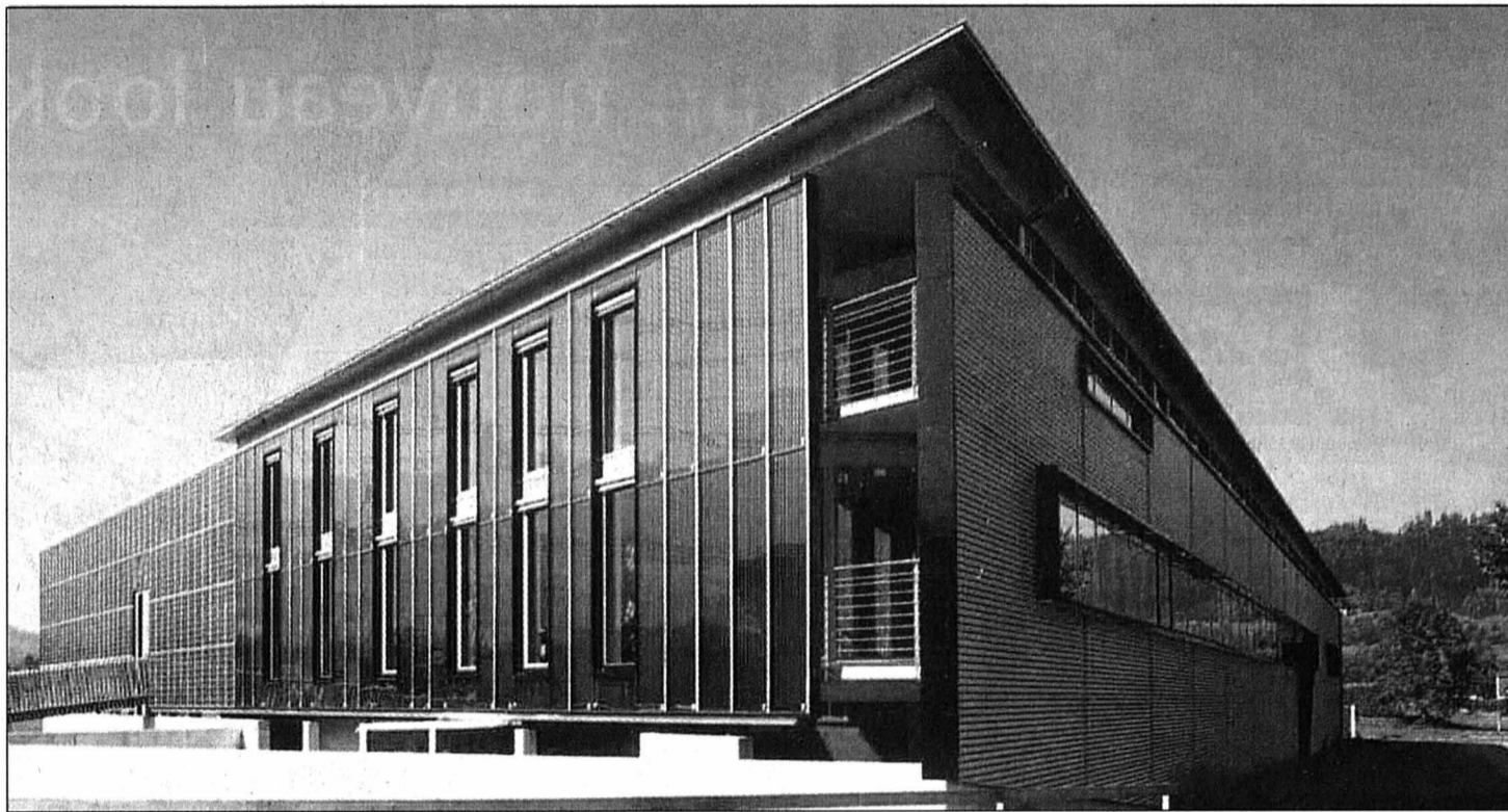
Des capteurs solaires en façade (photo: une entreprise sise en Autriche), mais pas encore sur des façades en acier.
