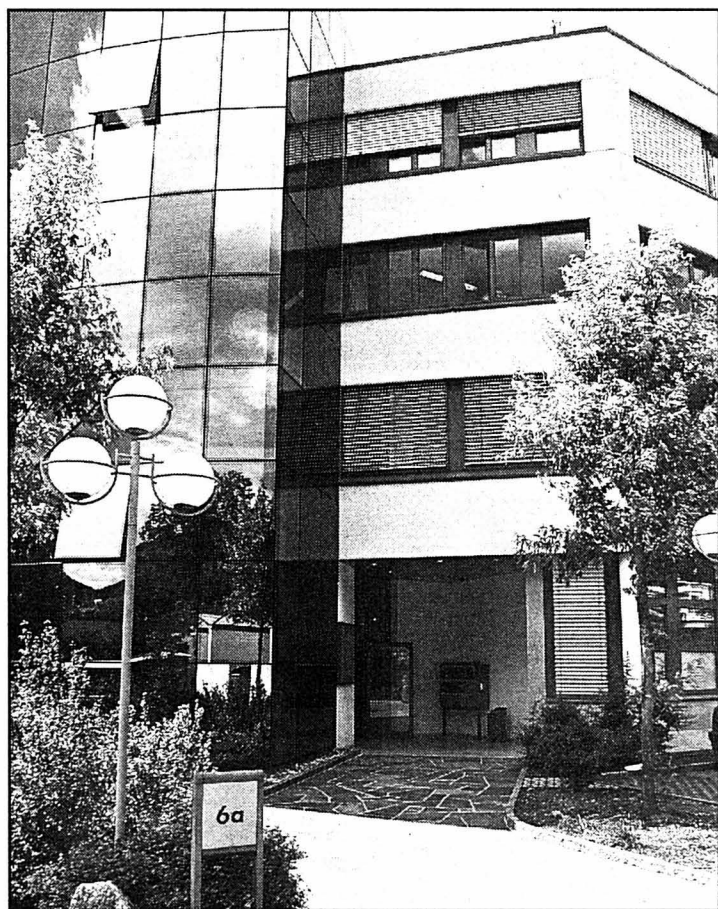
L'entreprise Cardintell va déménager début 2002 de ses locaux de Puits-Godet, à Neuchâtel, dans une nouvelle usine qu'elle va construire à Fontaines. photo Galley
