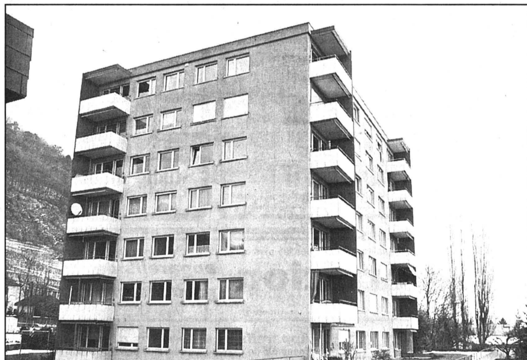
Un opérateur privé de téléphonie mobile veut dresser une antenne sur cet immeuble des Prés-Guëtins. photo Marchon
