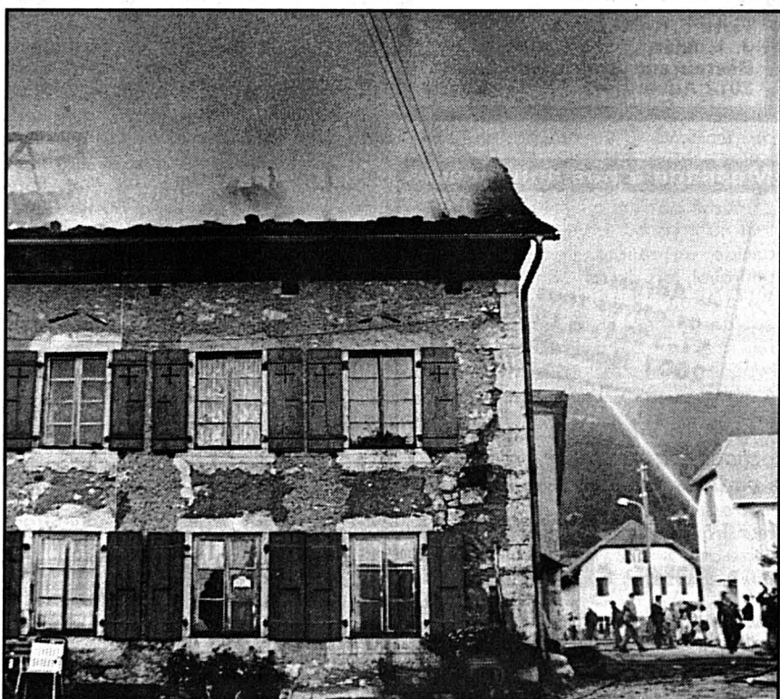
ZONE D'HABITATION — Elle n'a pas été touchée par les flammes, mais a subi d'importants dégâts d'eau.
