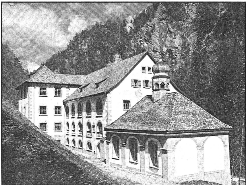
BAD PFÄFERS - Ce luxueux établissement de style baroque vient d'échapper à la démolition.
