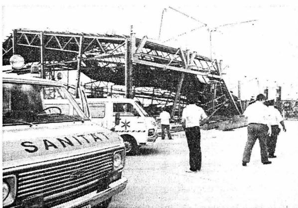
C'est alors que les ouvriers hissaient le toit préfabriqué d'un hangar en construction à l'aéroport international de Bâle, que l'accident s'est produit. Sous le poids excessif de l'assemblage, pour des raisons inconnues jusqu'à maintenant, toute une partie de la construction s'est effondrée. Ecrasant et tuant deux personnes. Les premiers secours, immédiatement dépêchés sur place, n'ont pu que constater le drame. (Keystone)
