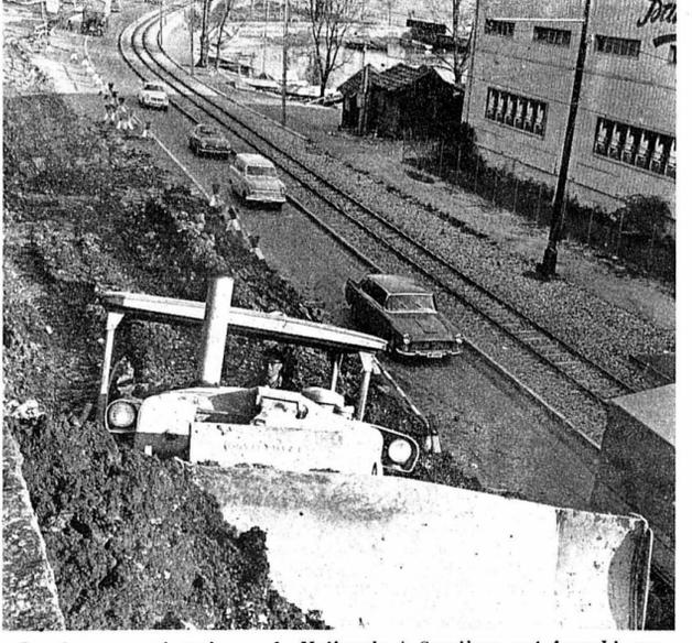
Les travaux entrepris sur la Nationale à Serrières ont franchi une nouvelle étape, à laquelle nous avions fait allusion à plusieurs reprises: l'abattage du mur situé à quelques dizaines de mètres à l'ouest du carrefour du Dauphin. Il s'agissait de supprimer le roc sur une largeur de deux à trois mètres et une longueur d'une dizaine de mètres.
