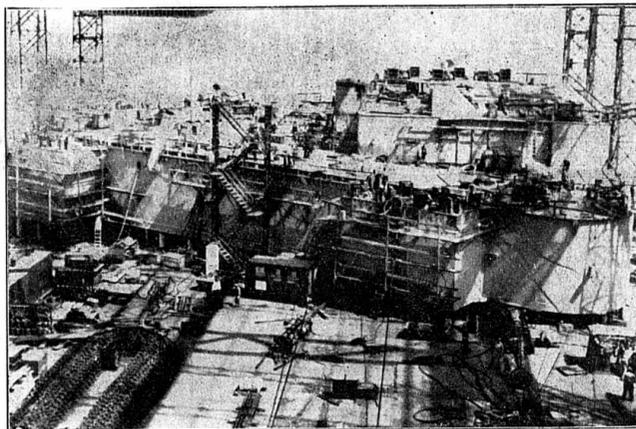
Les Etats-Unis s'entourent d'une chaîne de sentinelles: les îles-radar, dont les appareils surveillent nuit et jour l'horizon. Notre photo montre la première de ces îles artificielles, encore ancrée au port de Quincy (Massachusetts). Elle est montée sur un « dock » triangulaire et pèse 6000 tonnes. Cet Argus aux yeux compliqués sera fixé à 170 km. de la côte atlantique.
