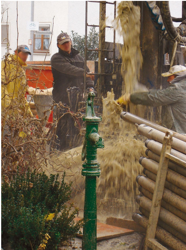
Abb. 6 Der Austritt artesisch gespannten Grundwassers führt zu Verschmutzungen und kann Schäden verursachen. Foto: Wolfgang Engesser
