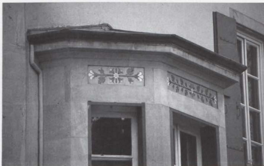
«Azulejos», faubourg de l'Hôpital 94, à Neuchâtel.
