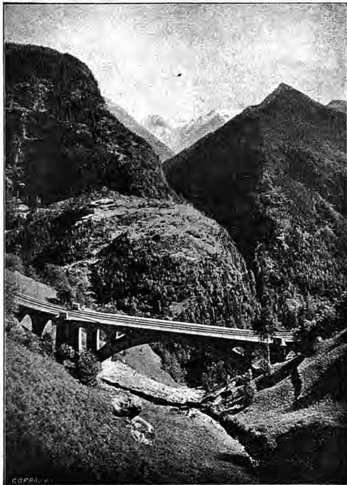
Pont de Finhaut
