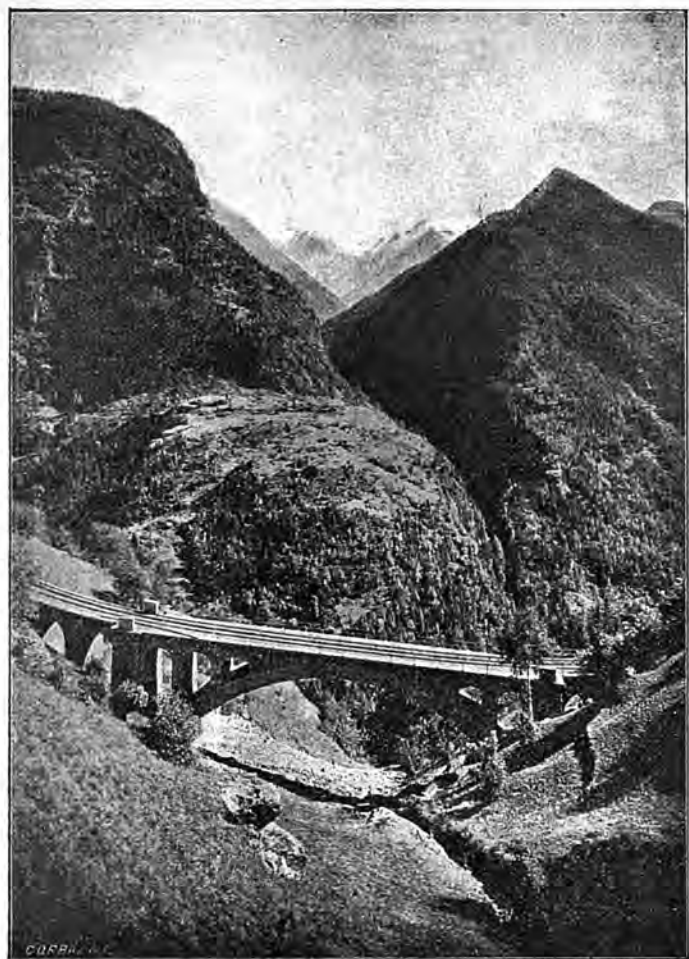
Pont de Finhaut
