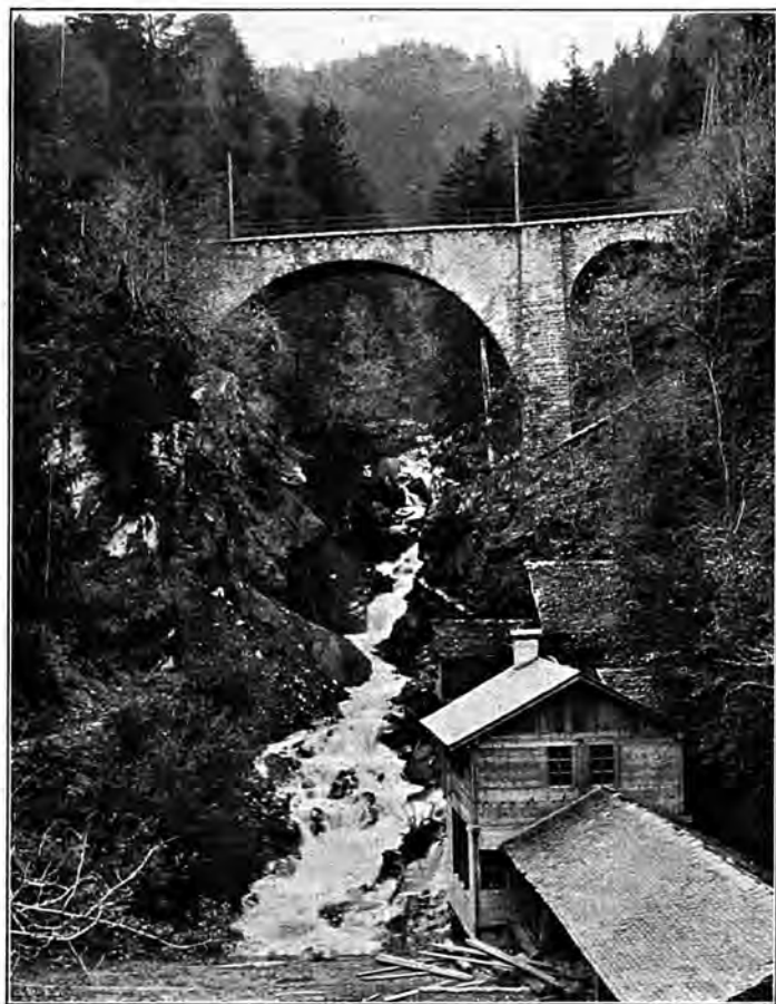
VIADUC DE LA TINE (Cliché J. Monod.) (Ligne Monthey - Champéry)
