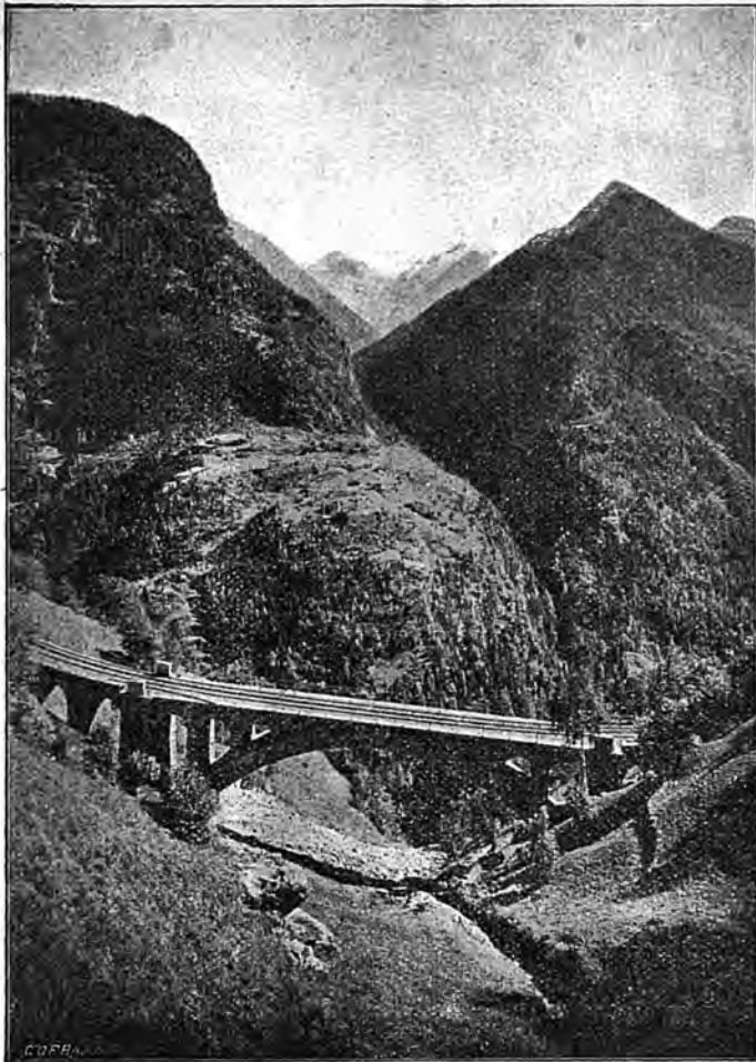
Pont de Finhaut
