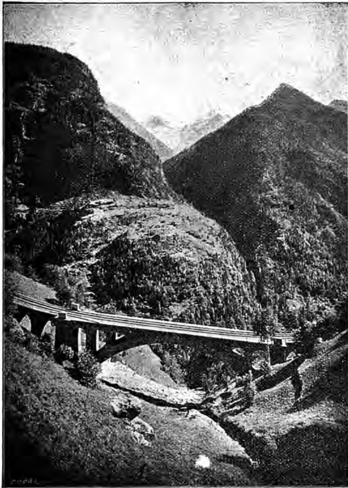
Pont de Finhaut
