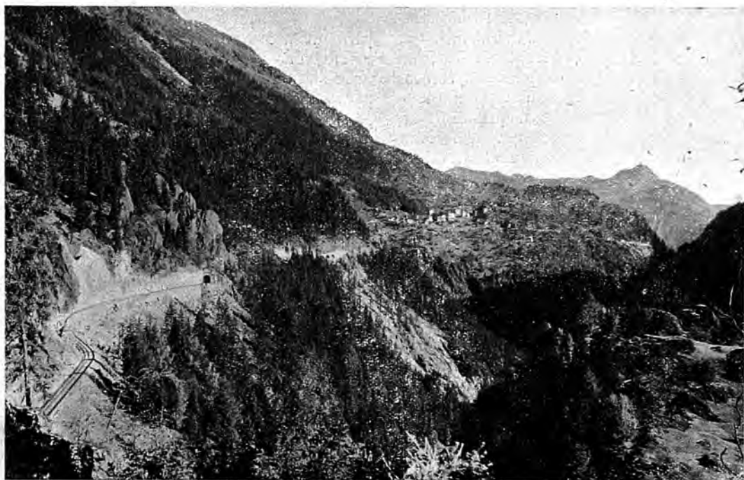
FINHAUT ET LA LIGNE ÉLECTRIQUE
