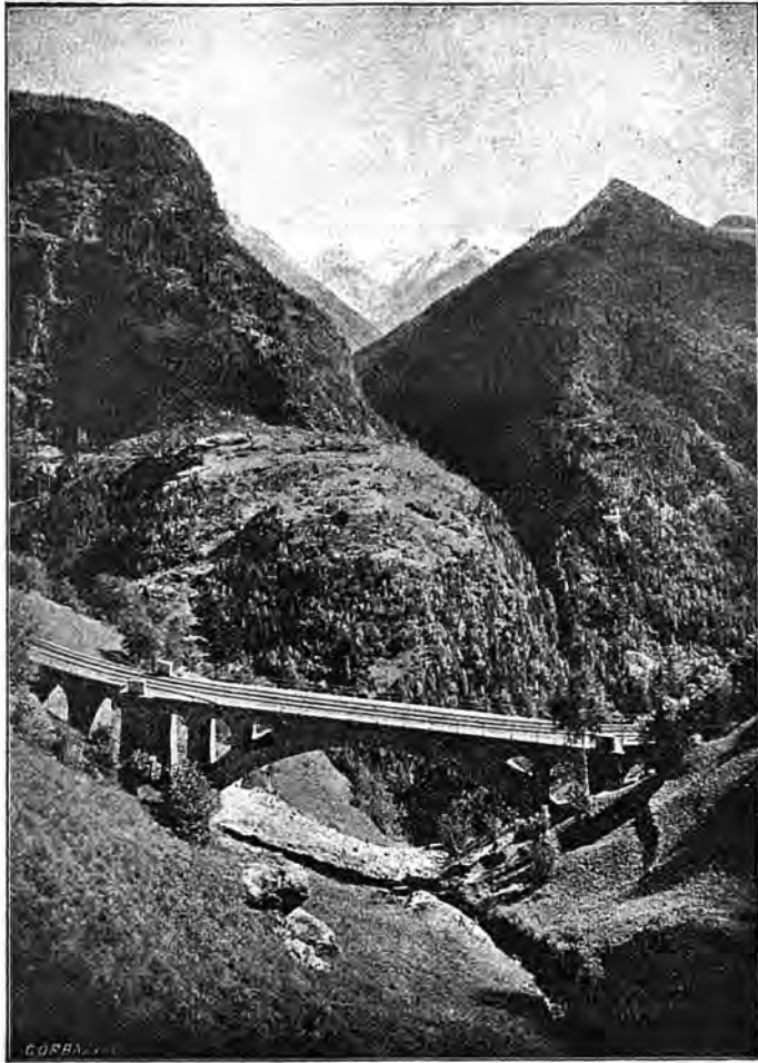
Pont de Finhaut
