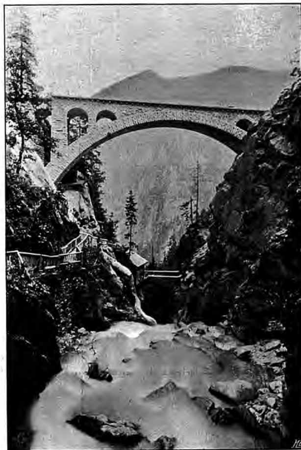
PONT DU TRIÈGE (Cliché Jullien frères).
