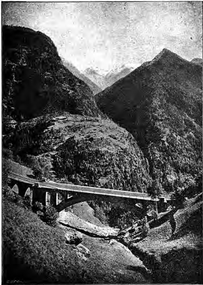
Pont de Finhaut
