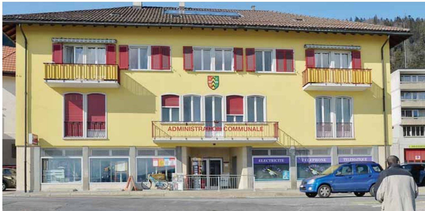
Les médecins du cabinet de groupe ont traversé moult péripéties avant de pouvoir acquérir l'immeuble de l'ancienne administration communale de Fontainemelon. ARCHIVES RICHARD LEUENBERGER
